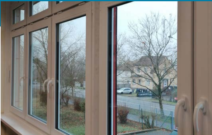
Dreischeiben-Wärmeschutz-Verbund-Verglasung im Bürogebäude aus dem Jahr 1996.
